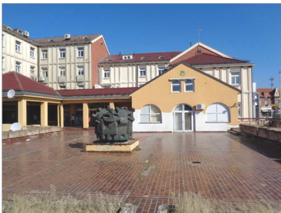
Slika 4. Poslovni centar Terme, pogled s platoa zgrade
