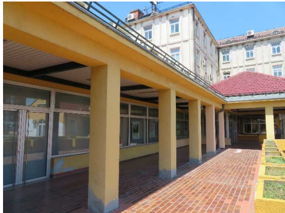
Slika 5. Poslovni centar Terme, pogled s platoa zgrade
